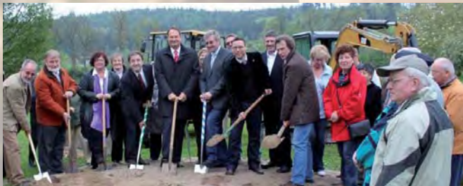
Der erste Spatenstich
