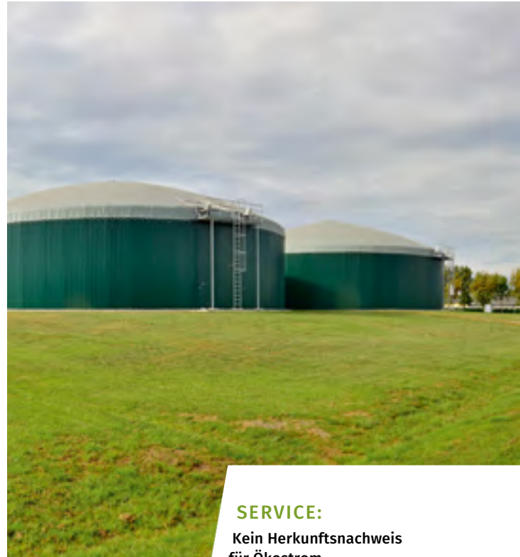
Biogasanlage Neutrebbin des EnviTec Stromkontor
