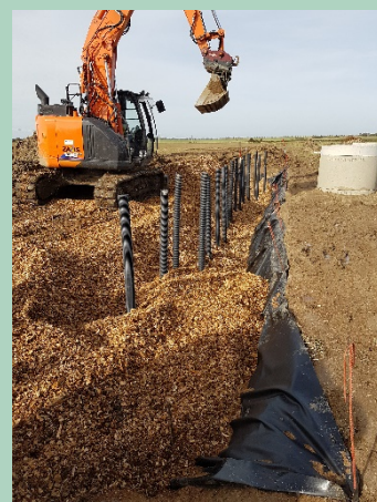
Bild 4: Reaktiver Graben im Bau (Teilprojekt 1)
