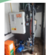
Im Projekt SAFT wurde eine Anlage zur Ansäuerung der Gülle nachgerüstet, die über eine pH-Sonde und einen Prozessbehälter außerhalb des Stallabteils gepumpt und dort automatisch mit Schwefelsäure versetzt.
