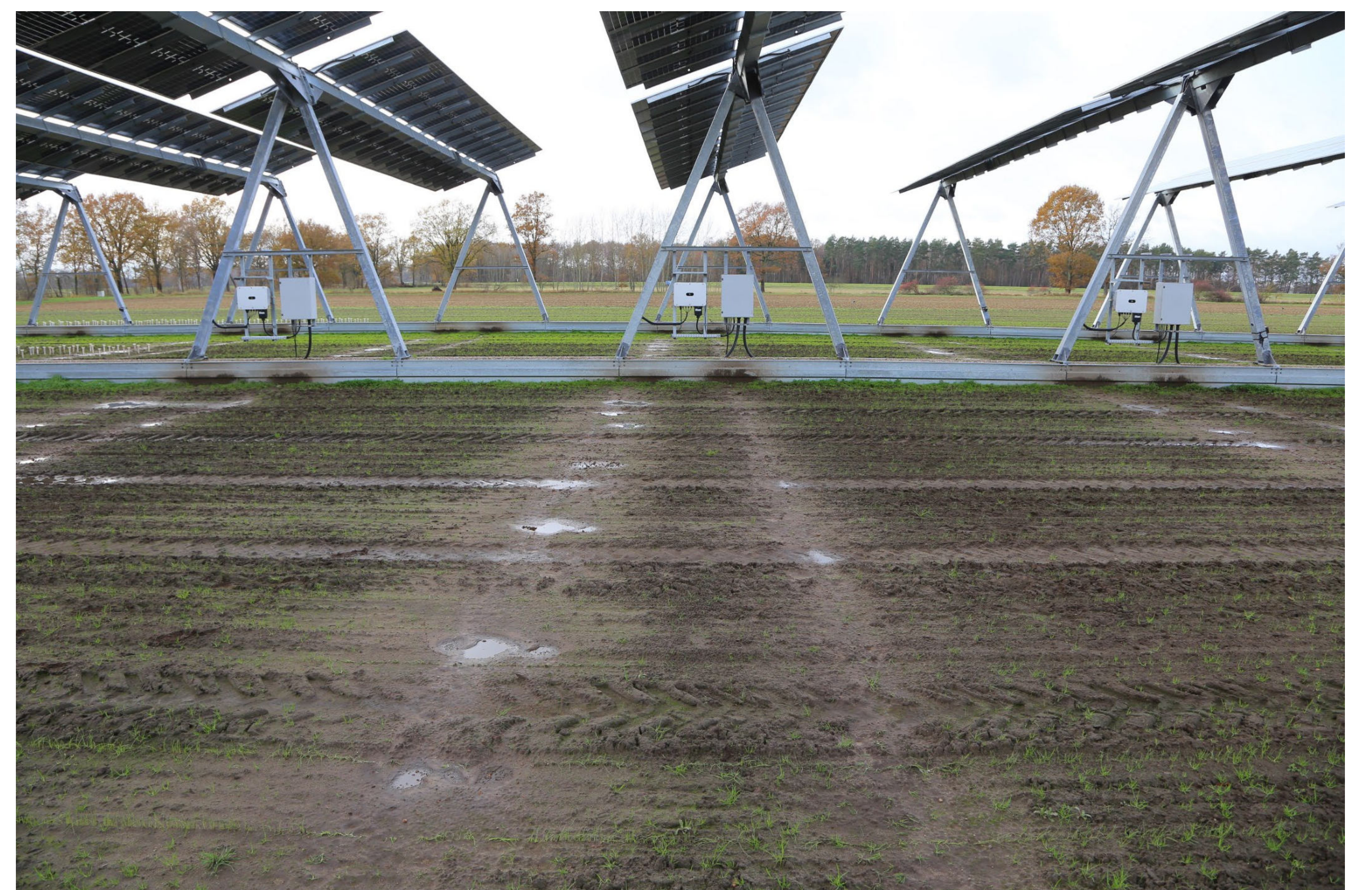
Abbildung 3: Abtropfkanten unterhalb der Solarmodule. Der Splash behindert das Pflanzenwachstum.
