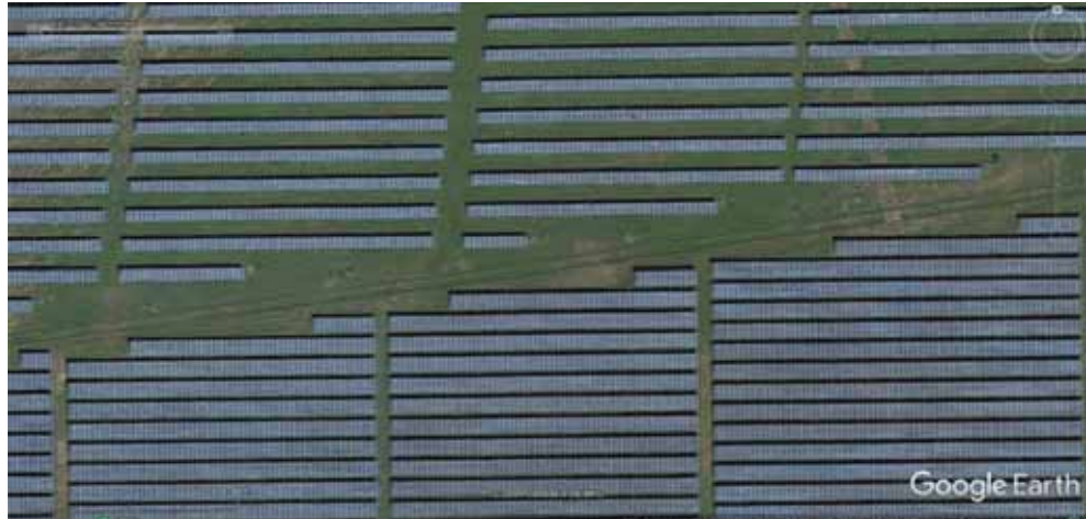
Abbildung 1-9: Vergleich differenter Bauweisen am Beispiel von 2 Solarparks auf dem ehemaligen Flugplatz Fürstenwalde (BB). Luftbildquelle: google earth © 2019 GeoBasis-DE/BKG © 2009, Aufnahmedatum 06.06.2018, verändert, Orientierung Nord
