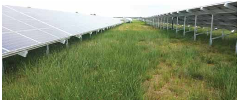
Abbildung 1-5: Reihenabstand von ca. 5,5 Metern in der PVA Finow II (BB). Von der Sonne beschienene Fläche ca. 4 - 4,5 m Breite
