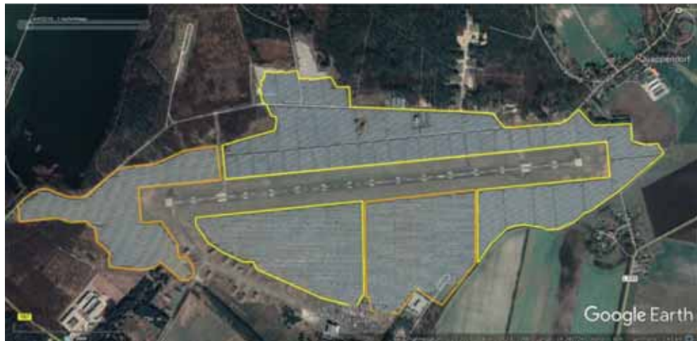
Abbildung 3-11: Solarpark Neuhardenberg 2019 mit den 2012 errichteten 4 verschiedenen PVA. Die Linienfarben heben die jeweiligen Grenzen zwischen den einzelnen PVA hervor (Luftbildquelle: © 2009 GeoBasis-DE/BKG, © 2019 CNES Airbus, © 2018 Google).
