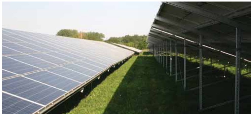
Abbildung 1-8: Reihenabstand von ca. 2 Metern in einer PVA südlich eines ehemaligen Flugplatzes östlich Fürstenwalde (BB). Von der Sonne beschienene Fläche ca. 0,8 m Breite
