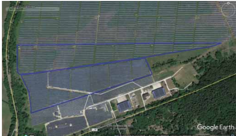
Abbildung 3-4: Untersuchungsgebiet einer Studie der leguan gmbh beim Vergleich von 2 in der Bauart verschiedenen PVA auf dem auf dem ehemaligen Flugplatz Fürstenwalde Luftbildquelle google earth © 2019 GeoBasis-DE/BKG © 2009, Aufnahmedatum 06.06.2018, verändert, Orientierung Nord
