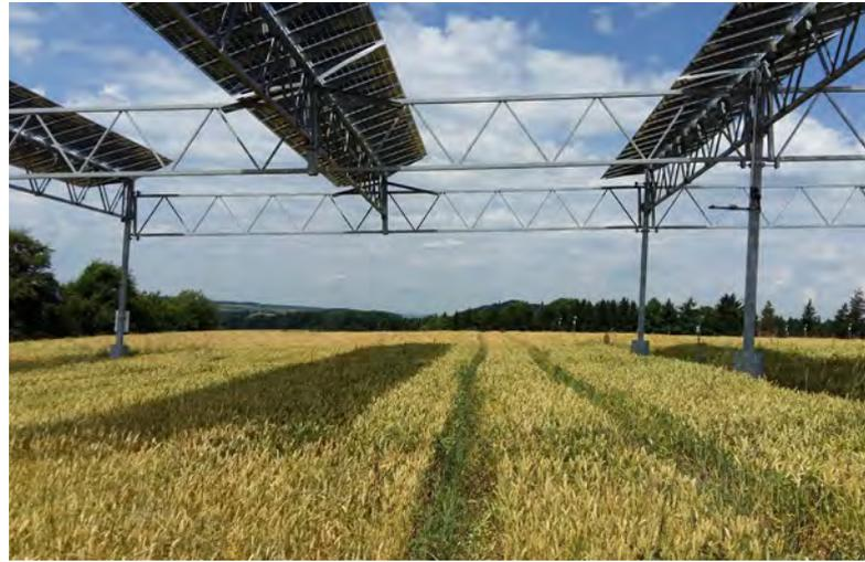
Abb. 48 Die Schattenstreifen der Solarmodule wandern mit dem Sonnenstand. © Universität Hohenheim.
