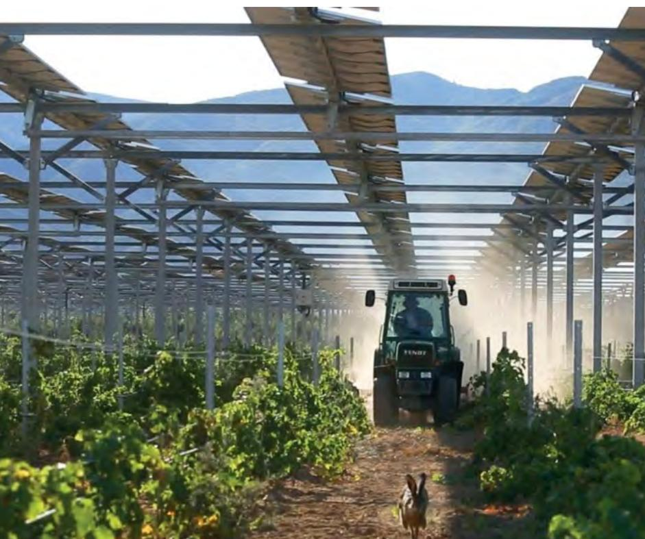
Abb. 44 Hoch aufgeständerte Anlage mit durchgängigen Modulreihen. © Sun'Agri
