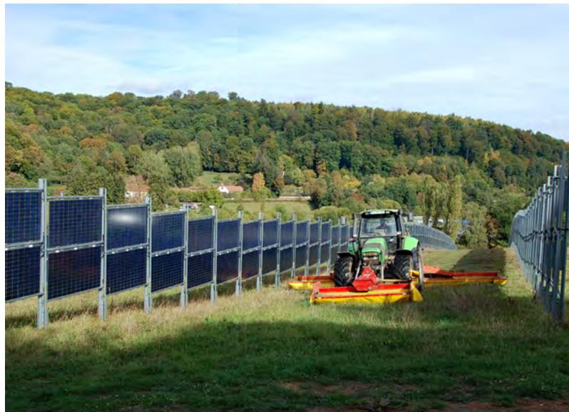
Abb. 31: Vertikal errichtete, bifaziale Module im Solarpark in Eppelborn-Dirmingen, Saarland, mit 2 MW<sub>p</sub> Leistung, errichtet von Next2Sun. © Next2Sun GmbH
