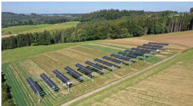
Abb. 50: Agri-PV-Anlage in Heggelbach mit einer Leistung von 194 kW<sub>p</sub> auf etwa einem Drittel Hektar. © Fraunhofer ISE
